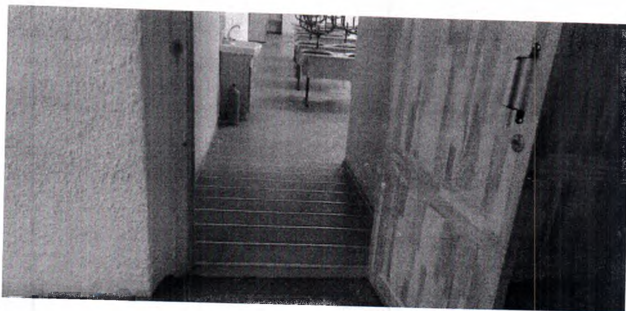
Фото №4. Демонтированы пороги.
