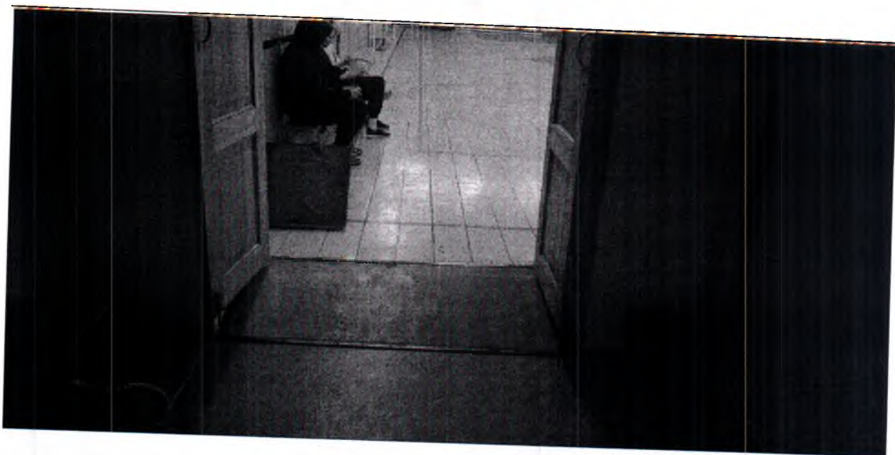
Фото №3. Демонтированы пороги.
